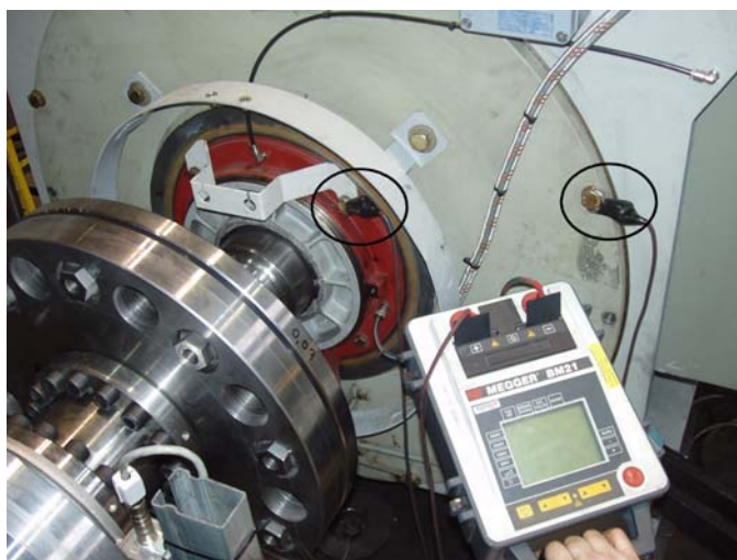
Figura 7-4 Medición de la resistencia de aislamiento de un cojinete de rodillos
